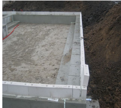
Eerste laag metselwerk ( 200 mm)
