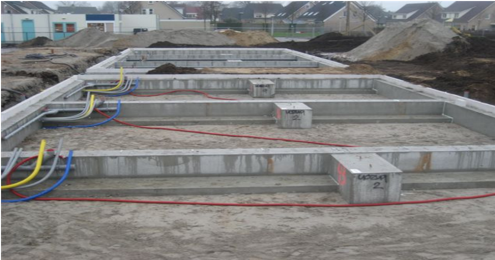
Een prefab fundering op "staal"
