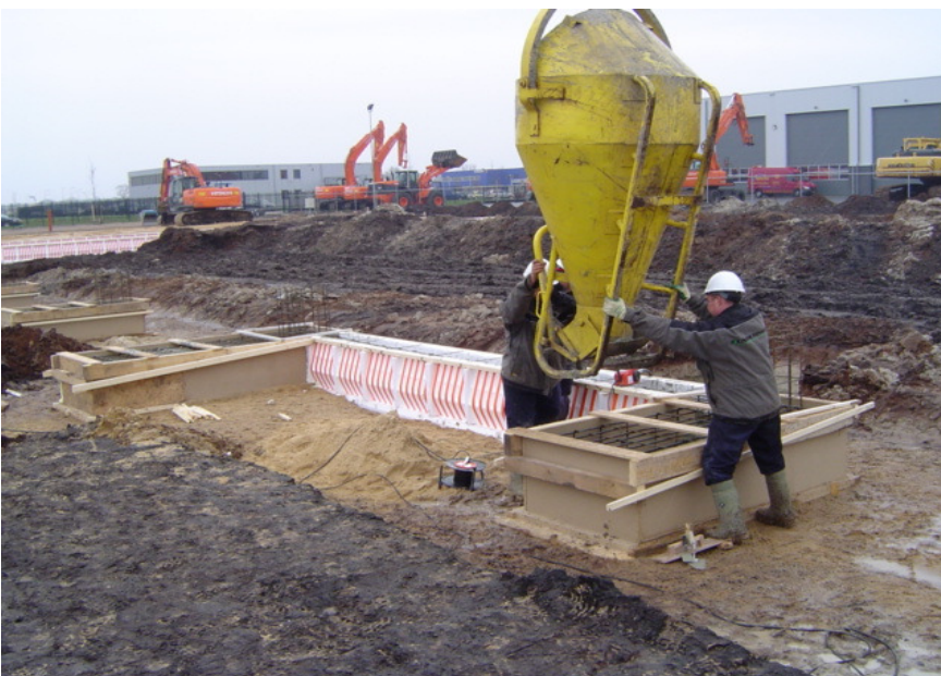
PS bekisting en betonpoeren in het werk gestort
